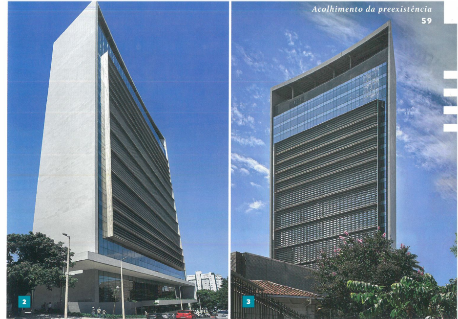
1 Mais de 30 anos separam a construção das duas torres ocupadas pela Cemig. O edifício da direita é o mais recente e não se confronta com o preexistente / 2 e 3 Na face norte, brises contêm células fotovoltaicas que captam luz solar e a convertem em energia
