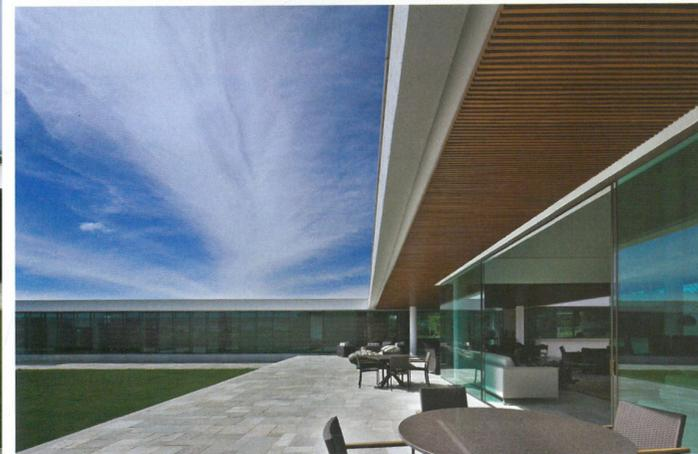
por portas de vidro temperado. A grande laje de cobertura apoiada em seis pilares que formam uma malha estrutural de 6 m x 10 m. O corredor de acesso aos dormitórios (são quatro suítes) recebeu fechamento de vidro e uma
